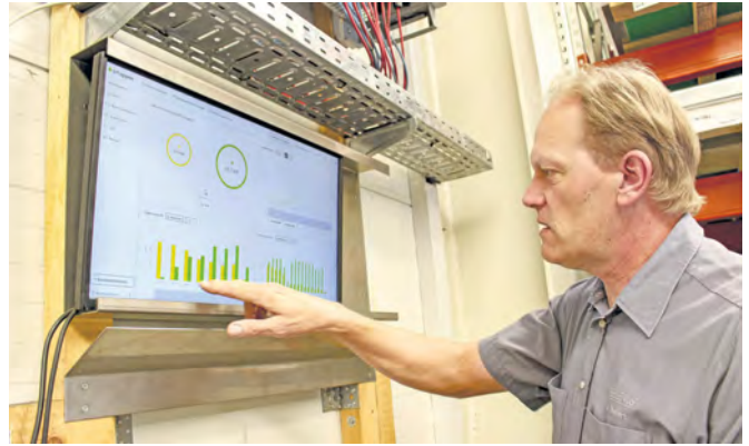
Belenus Firmeninhaber Alexander Theinert beim täglichen Blick auf die Anzeige der Photovoltaikanlage, die sich auf dem Dach des Gebäudes befindet.
